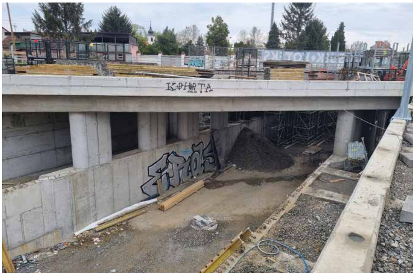
Pogled na gradilište podvožnjaka krajem travnja 2023.
