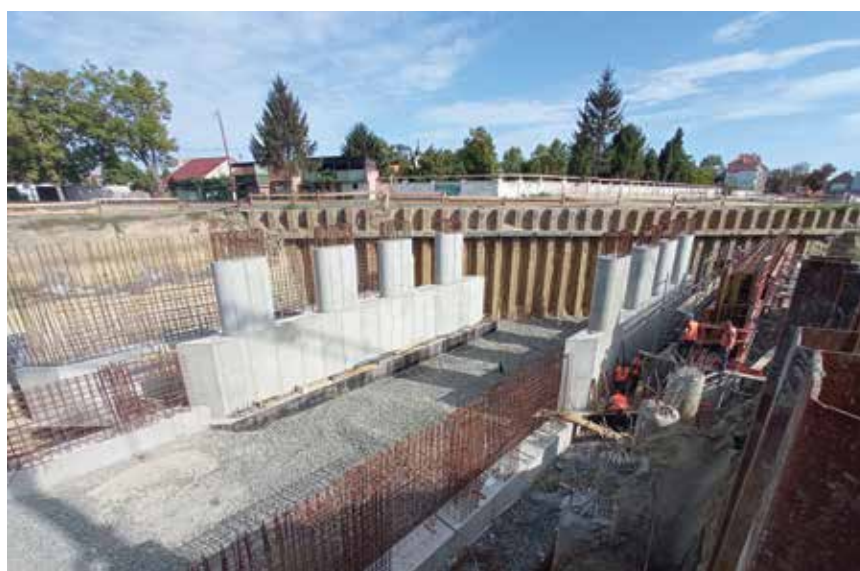
Detalji izvođenja potpornih zidova
