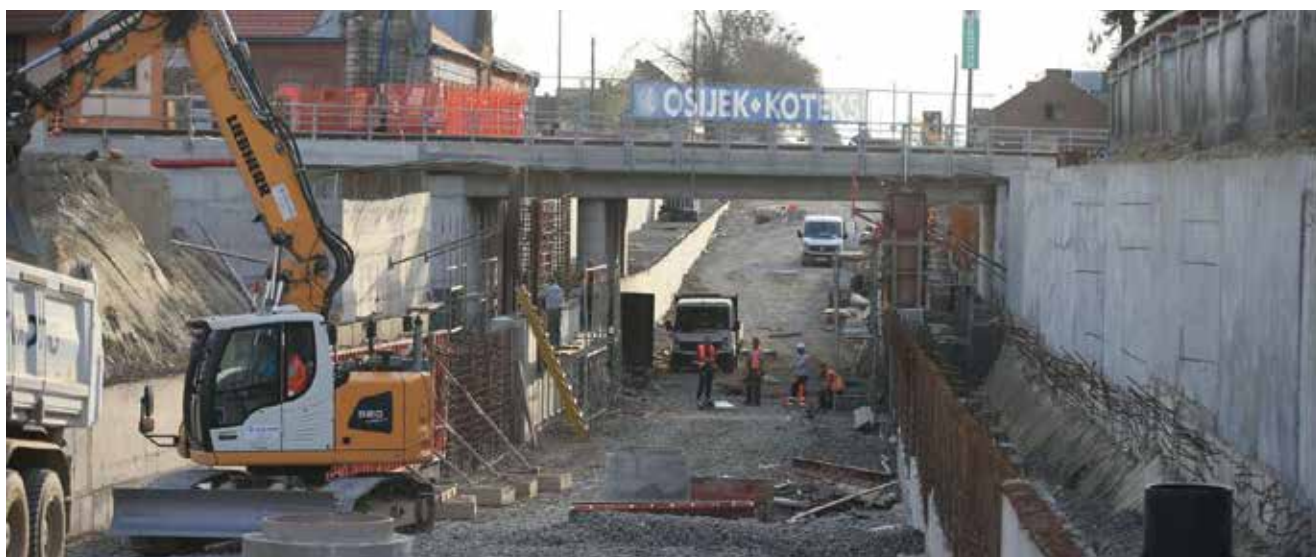
Detalj s gradilišta
