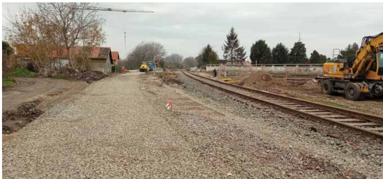
Priprema podloge za željezničku prugu na devijaciji
