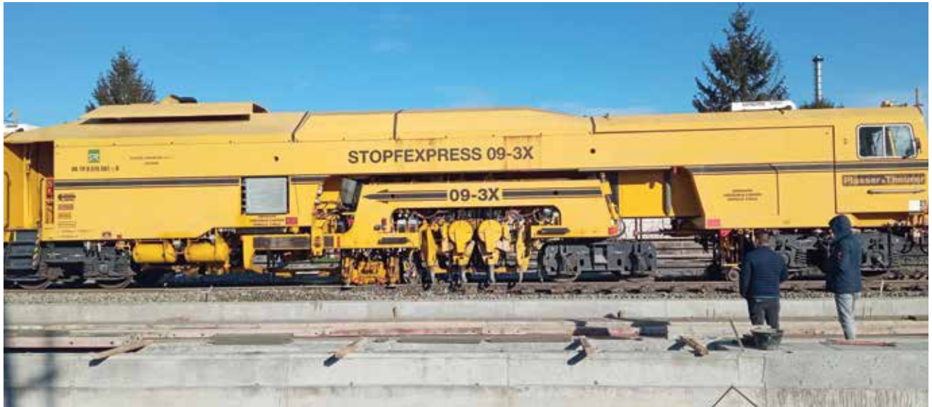
Radovi na novom dijelu željezničkog kolosijeka
