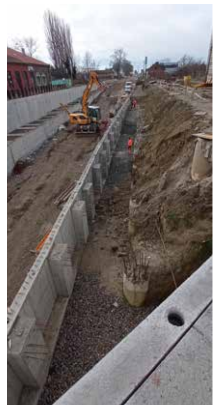
Radovi na pješačkoj i biciklističkoj stazi do izvedenih potpornih zidova
