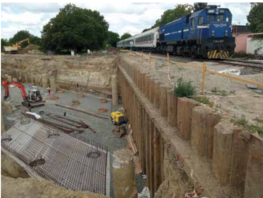
Radovi na gradilištu podvožnjaka izvođeni su bez zaustavljanja željezničkog prometa
