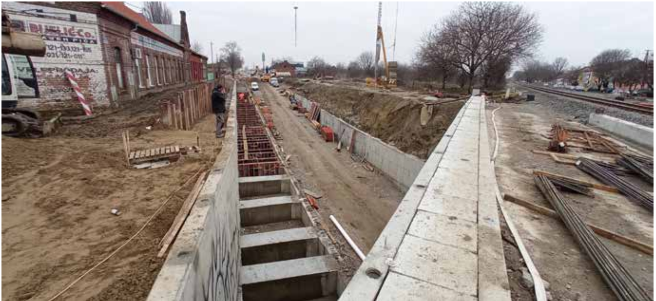
Zidovi su na nekim kampadama povezani poprečnim gredama
