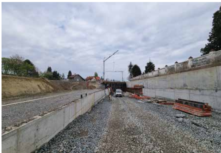
Pogled na gradilište u travnju 2023.
